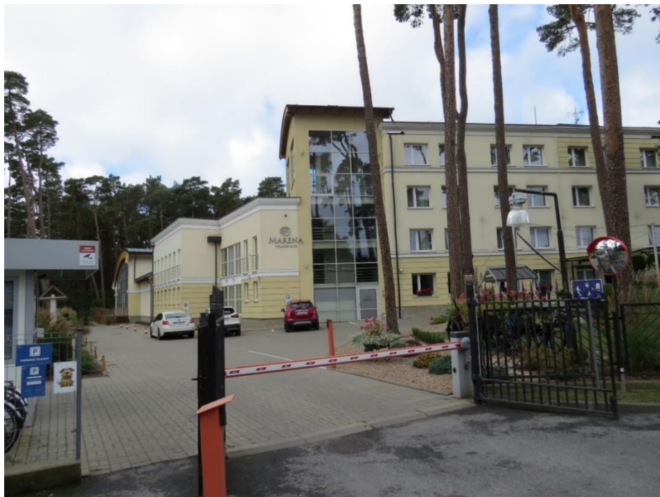
Fot. 1. Obszar opracowania w centralnej części widok od strony zachodniej w kierunku wschodnim. Widok na wejście do budynku ośrodka wypoczynkowego (autor: S. Jurzyk-Nordlów 2022 r.).
