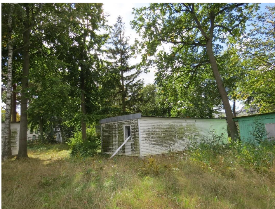
Fot. 18. Roślinność trawiasta spontaniczna siedlisk ruderalnych i wielogatunkowe zadrzewienia towarzyszące nietrwalej starej zabudowie (autor: S. Jurzyk-Nordlów 2022 r.).
