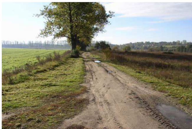
Zdjęcie 1 Droga dojazdowa do składowiska w Kraśniku gm. Węgorzyno
