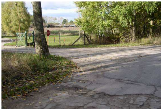
Zdjęcie 5 Droga dojazdowa do składowiska w Smolećcinie
