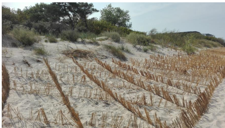
Fot. 39. Mierzeja Dziwnowska z zastosowaną ochroną biotechniczną ograniczającą erozję eoliczną.
