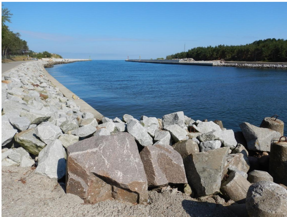
Fot. 1. Zabudowa techniczna brzegów końcowego odcinka Dziwny.
