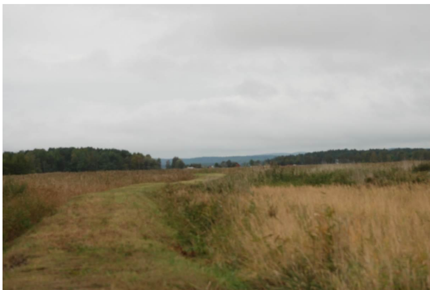
Fot. 3. Wał przeciwpowodziowy w Międzywodziu, od strony Zalewu Kamieńskiego (fot. Zakrzewski 2016)
