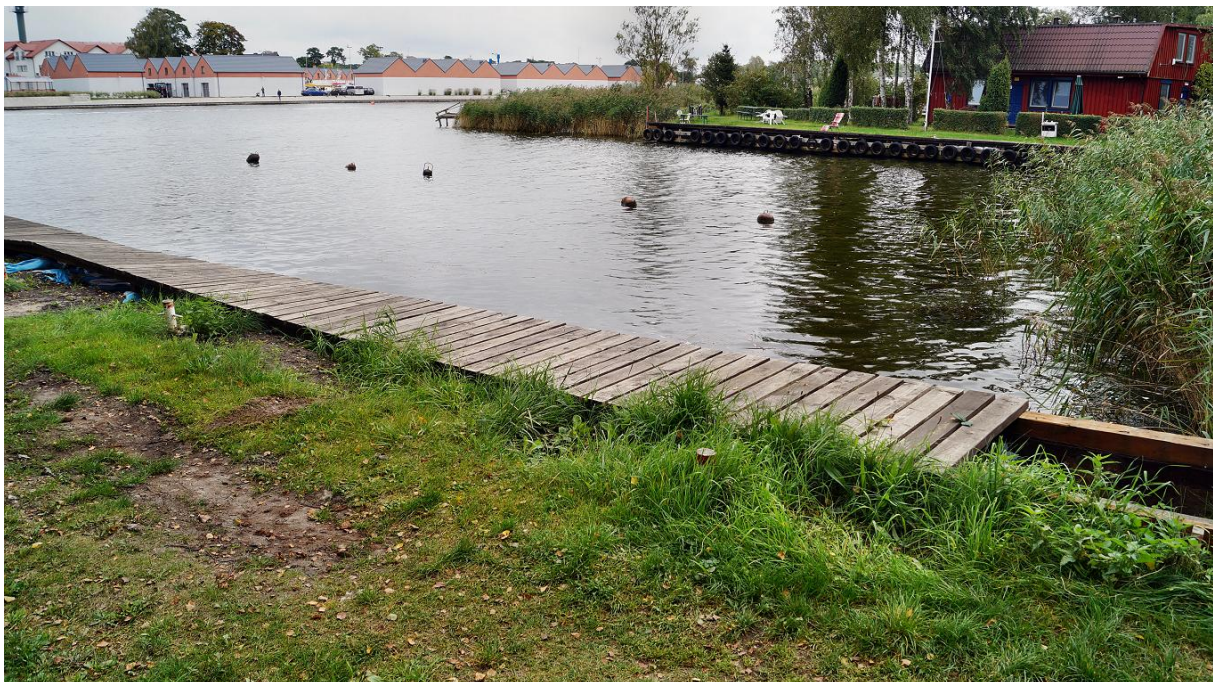
Fot. Przystań przy ul. Spadochroniarzy Polskich w Dziwnowie – stan obecny.
